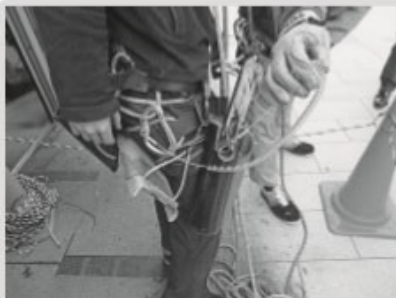
清掃用具はコンビスクイジー(ハッスルズ)で、落下防止措置のカールコードも接続されており、○。
