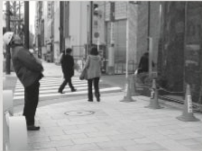
立入禁止区域の確保は、カラーコーンとトラロープで確保しており、○。
