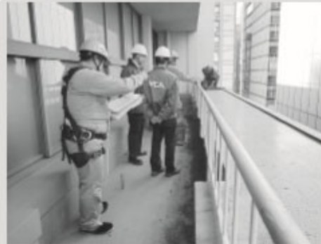
右奥作業員のロープの移設中。墜落防止措置がなく、×。改善事例は、下写真2点。
