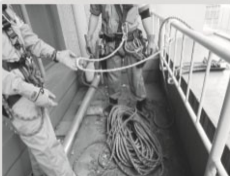
堅固な鉄製フェンスの支柱に安全帯のランヤードのフックを連結し、パラベット上で、ロープの移設作業。
