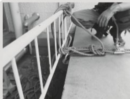
ライフラインに墜落阻止器具を連結し、身体保持器具(ブランコ台)搭乗直後に、ランヤードを外す。
