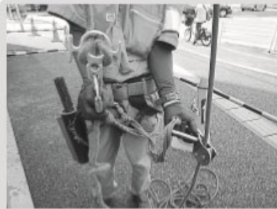
接続器具(下降器)は、角付エイト環のジェットマン。墜落阻止器具は、ストップフォーク。ランヤードが長い。指導事項、参照。
