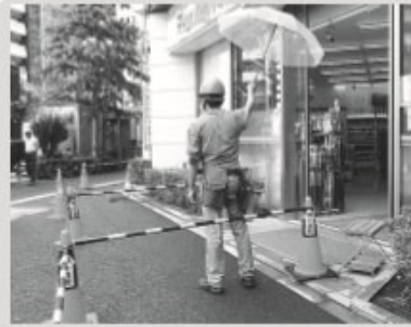
地上監視員を配備した立入禁止区域の確保と、エントランスでの歩行者に配慮した傘を使用した汚水飛散による対応措置。
